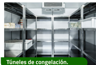
Túneles de congelación.
